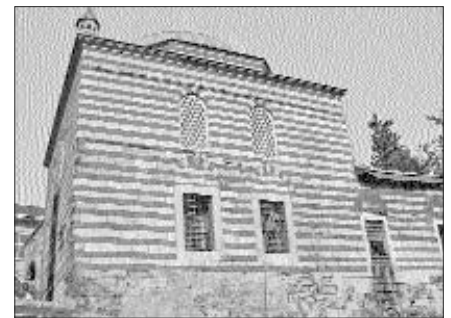
Sultan Selim Külliyesi'nin sıbyan mektebi
